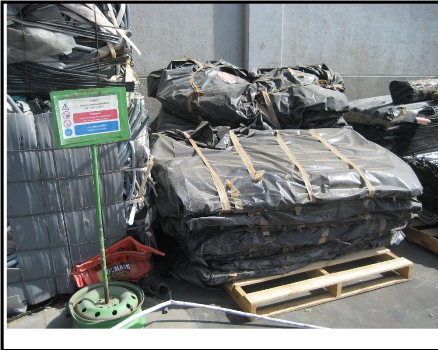
Figura 13 – Armazenamento de RCD com amianto devidamente sinalizado
