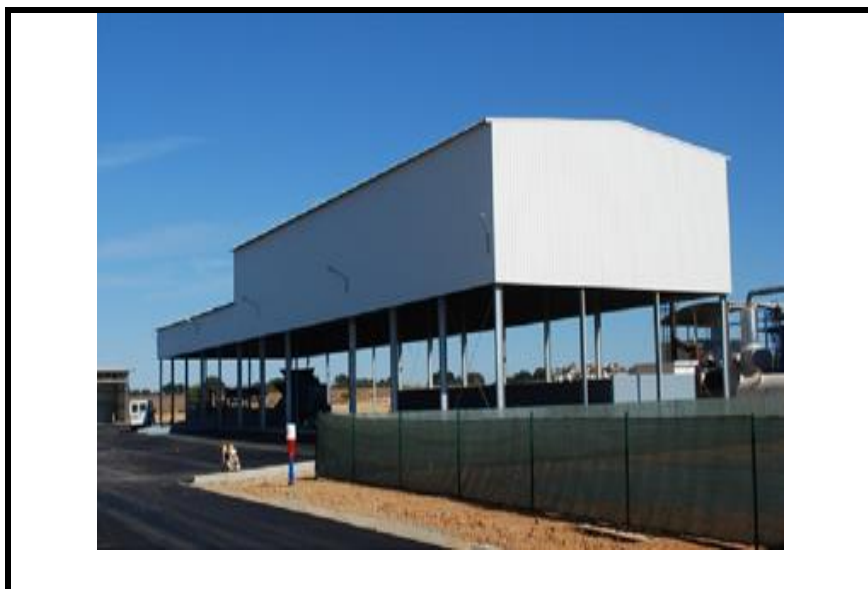
Figura 11 – Unidade de triagem de RCD
