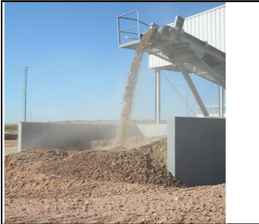
Figura 12 – Unidade de britagem de RCD
